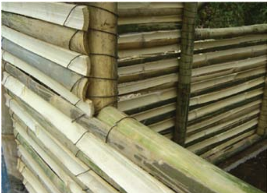
Imagen No. 6 Detalle de vivienda construida con bambú por INTECAP en Retalhuleu. Fuente: INDIS.
