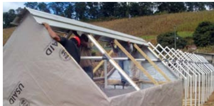
Imagen No. 27 Albergue de PVC. Fuente: SCEP
