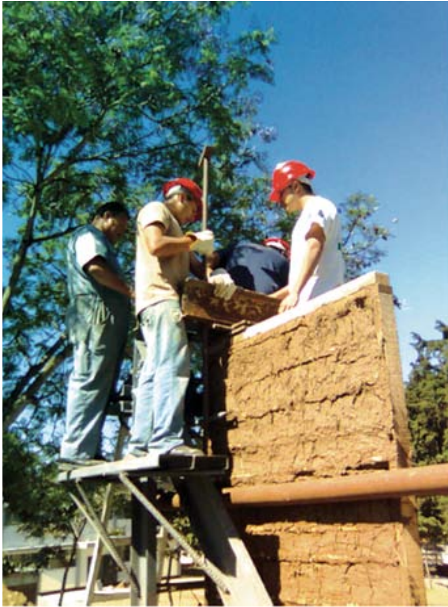
Imagen No. 12 Panel sometido a ensayos estructurales. Fuente: INDIS.
