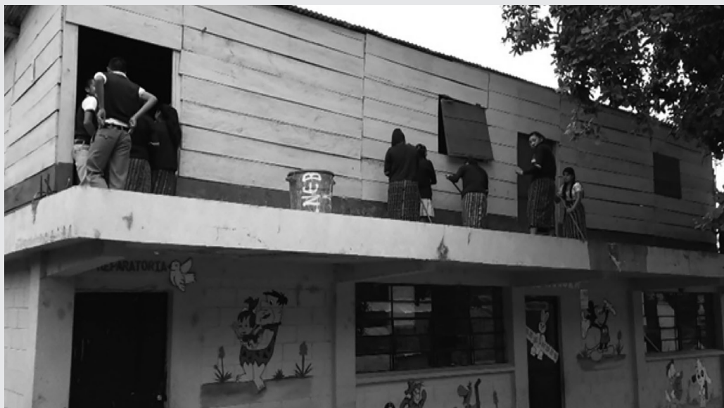
Foto 1. Contrastes de infraestructura escolar: aulas de un establecimiento oficial de ciclo básico construidas sobre aulas de una escuela oficial de párvulos
